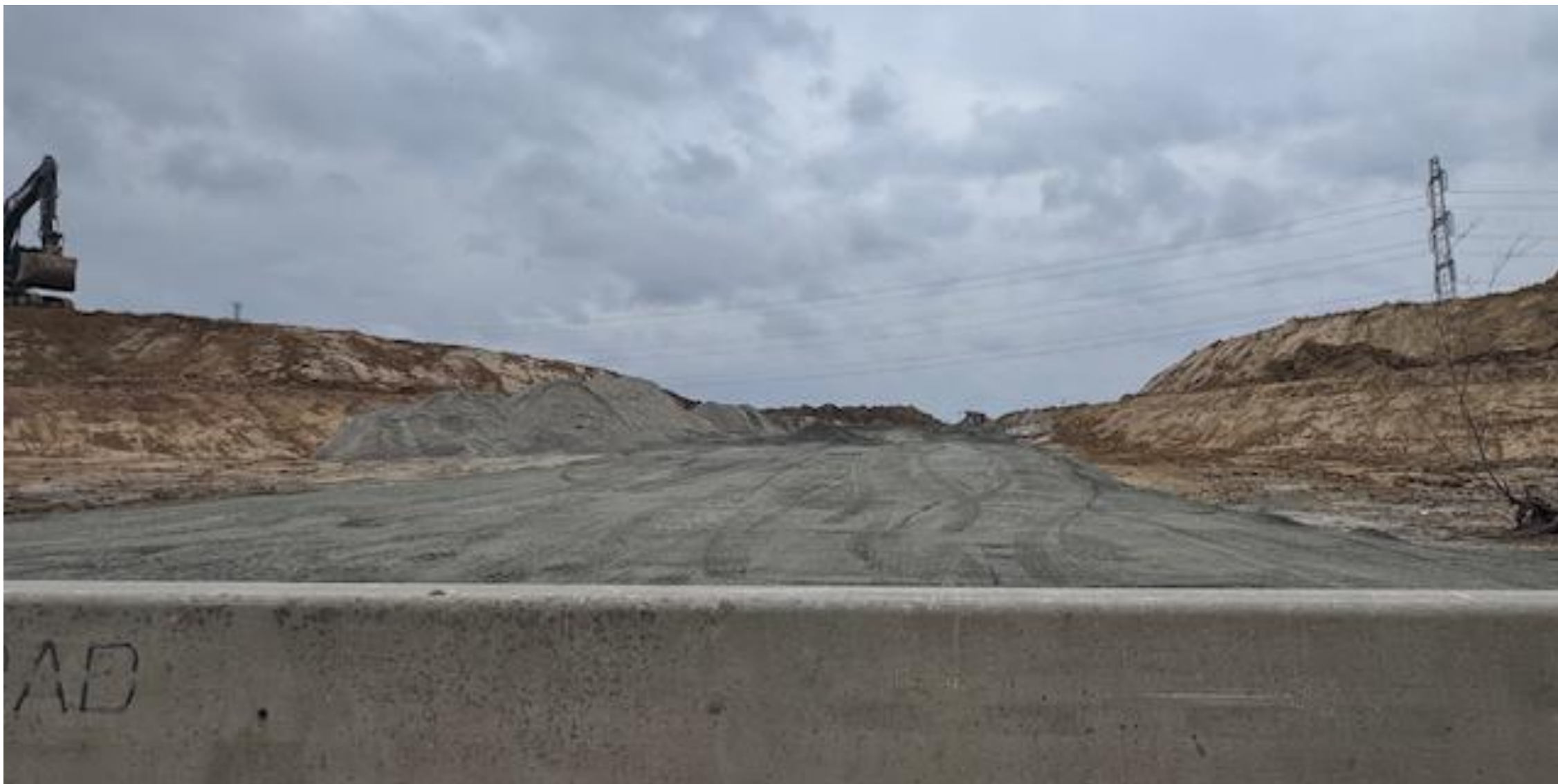
Foto af anlægsvejen fra Sydvej onsdag 11.03.26
